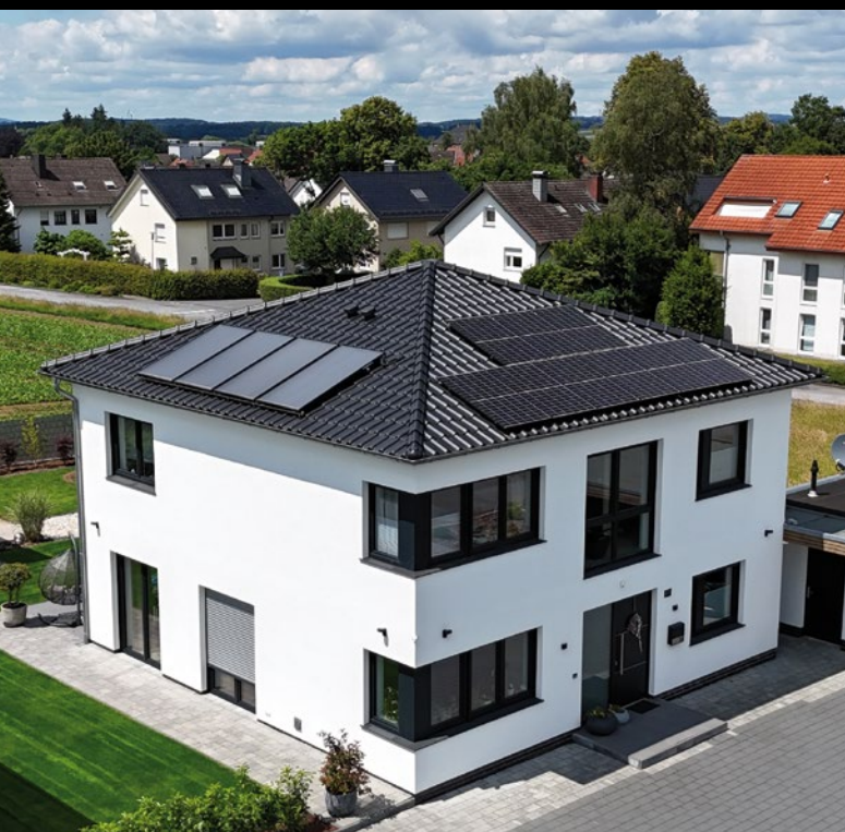
▲ 18 Black-Frame-Module Die PV-Anlage produziert ca. 7.000 kWh / Jahr Amortisationszeit der Investition ca. 8 Jahre
