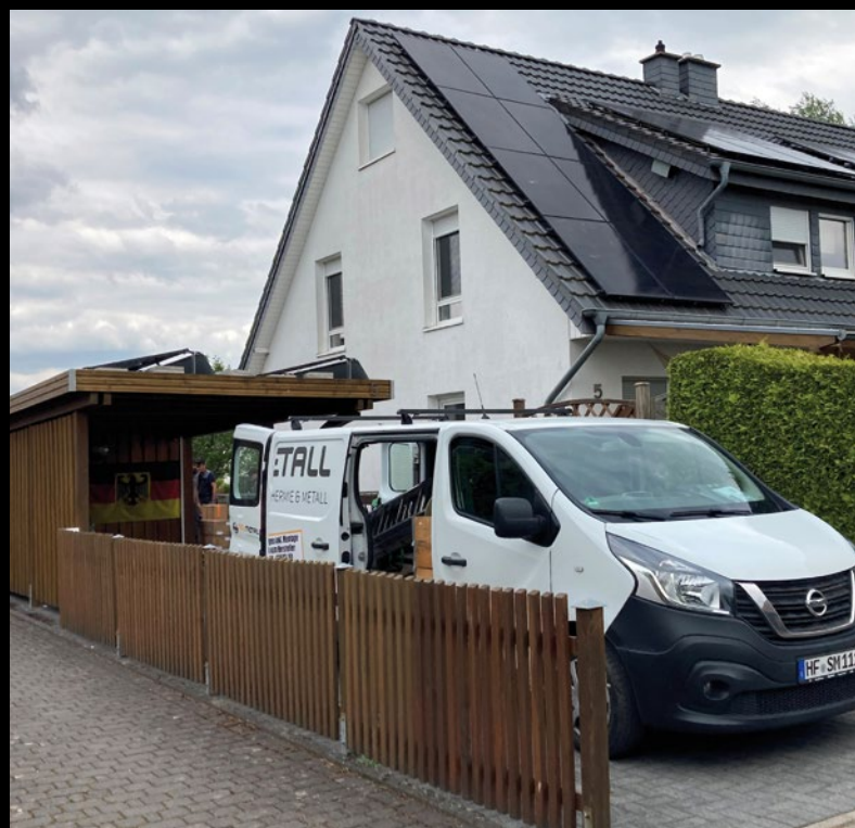
▲ 20 Glas-Glas-Module Die PV-Anlage produziert ca. 7.500 kWh / Jahr Amortisationszeit der Investition ca. 7 Jahre
