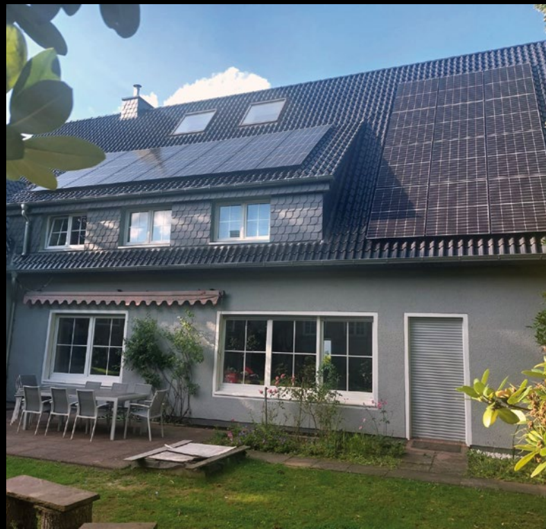
▲ 26 Black-Frame-Module Die PV-Anlage produziert ca. 10.000 kWh / Jahr Amortisationszeit der Investition ca. 8 Jahre
