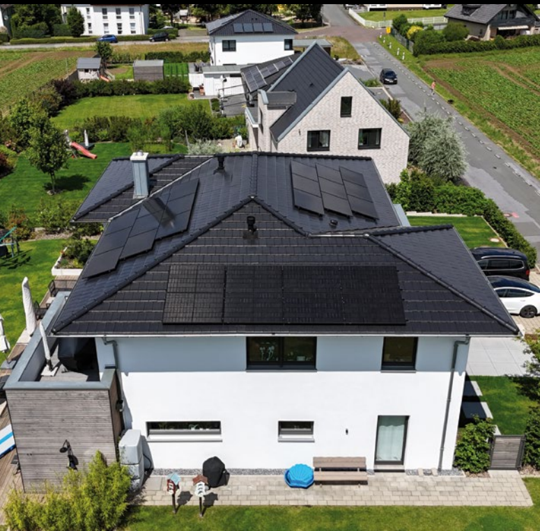
▲ 26 Full-Black-Module Die PV-Anlage produziert ca. 9.000 kWh / Jahr Amortisationszeit der Investition ca. 6 Jahre
